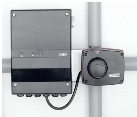
Obr.9 Směšovací ventil ESBE se servopohonem a regulátorem upevněným na držáku.
