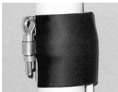
Obr. 10 Izolace čidla termoizolační páskou
