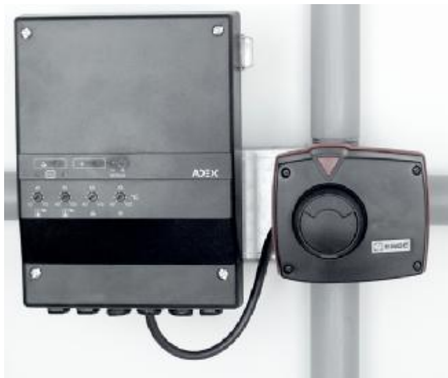
Regulátor upevněný na směšovacím ventilu
