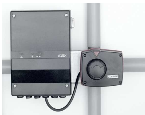
Obr. 8 Regulátor upevněný na držáku vedle servopohonu
