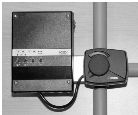
Obr. 30 Regulátor upevněný na držáku vedle servopohonu
