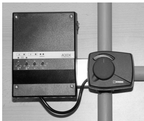
Obr. 30 Regulátor upevněný na držáku vedle servopohonu
